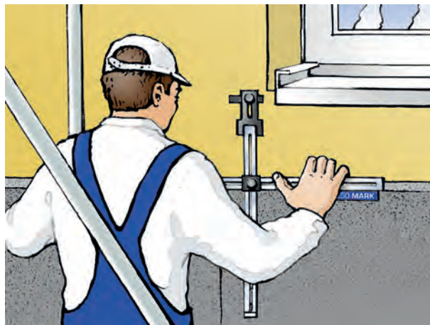
1. Aanbrengen van het sjabloon
