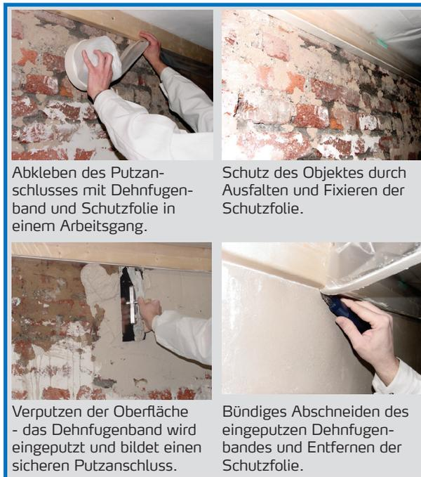
Abkleben des Putzanschlusses mit Dehnfugenband und Schutzfolie in einem Arbeitsgang.
